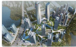
星河产业智能楼宇集中管理平台
